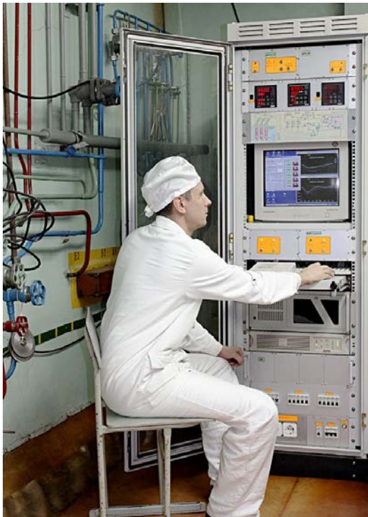
Внешний вид оборудования стенда сухого хранения
